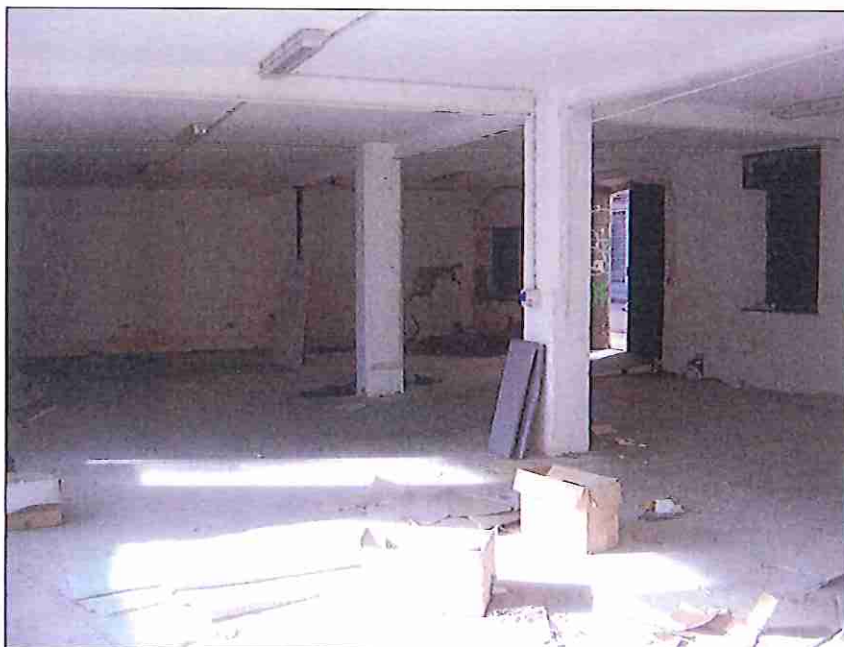
piano terra – attuale magazzino/laboratorio
