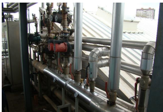
Collettori M/R riscaldamento
