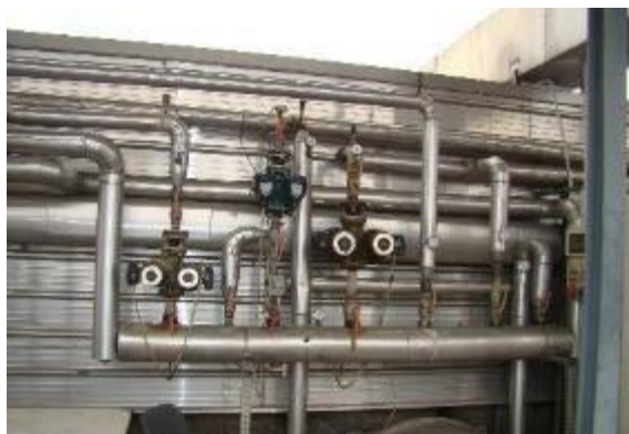
Collettore distribuzione acqua calda
